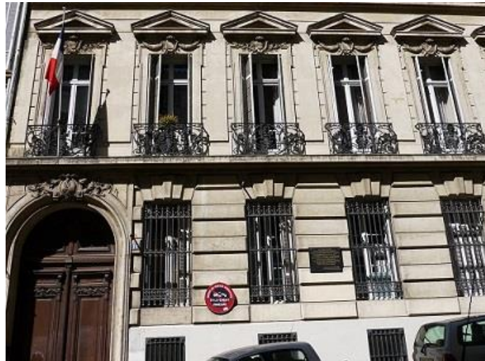
Façade de l'Hôtel de Cypières
