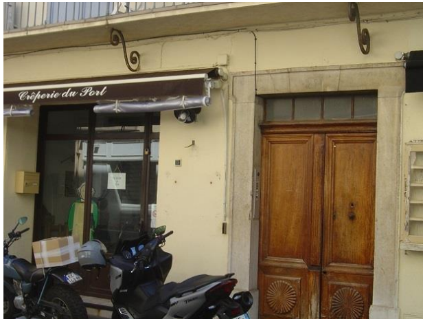
11. Porte d'entrée du 22 rue Thuret donnant accès aux appartements et la porte arrière donnant rue des casemates
